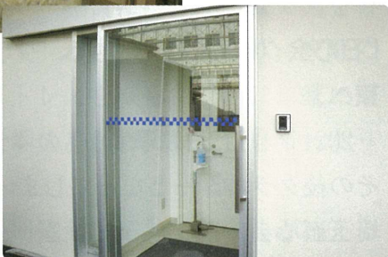
透析個室側の入口 （感染者用入口）
