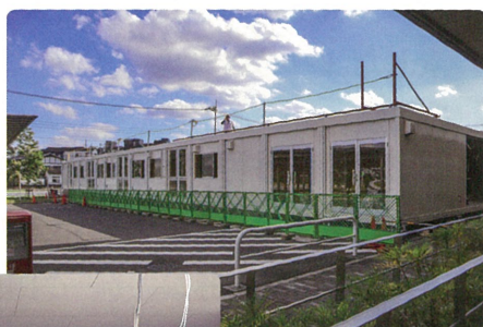
プレハブコロナ病棟写真（工事中）9/29 現在
