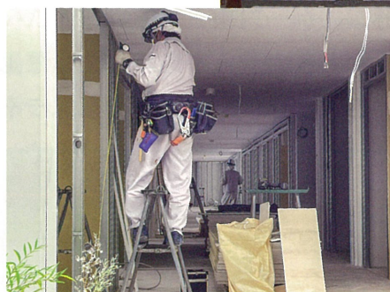
内装工事の様子 9/29 現在
