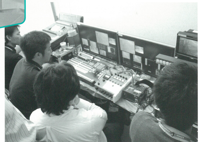
病院内に中継の機器が設置された
