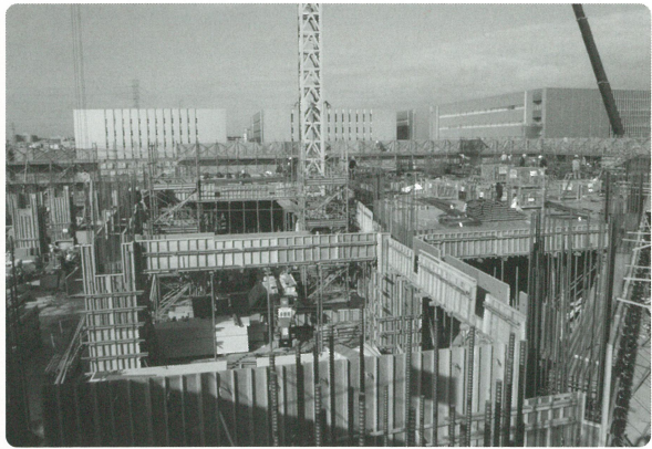
3階床及び躯体部分 (柱、壁)の「配筋、型枠」工事
