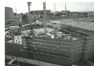
〈2階部分床の打設中 平成23年1月31日〉 工事もようやく2階部分に さしかかりました。
