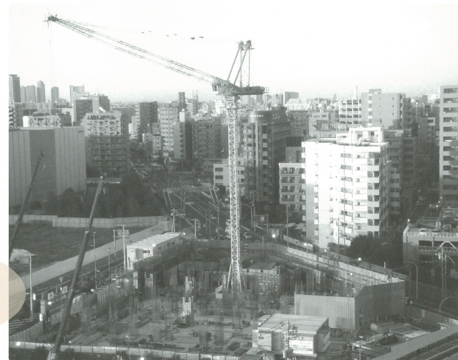
タワークレーンと 1階「立ち上がり」工事
