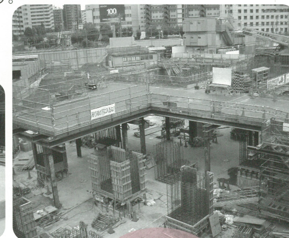
工事現場の全景
