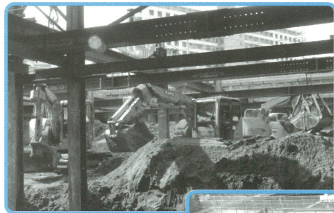
地下免震層をつくるための掘削工事
