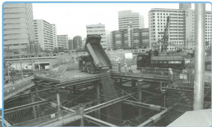
工事現場全体風景
