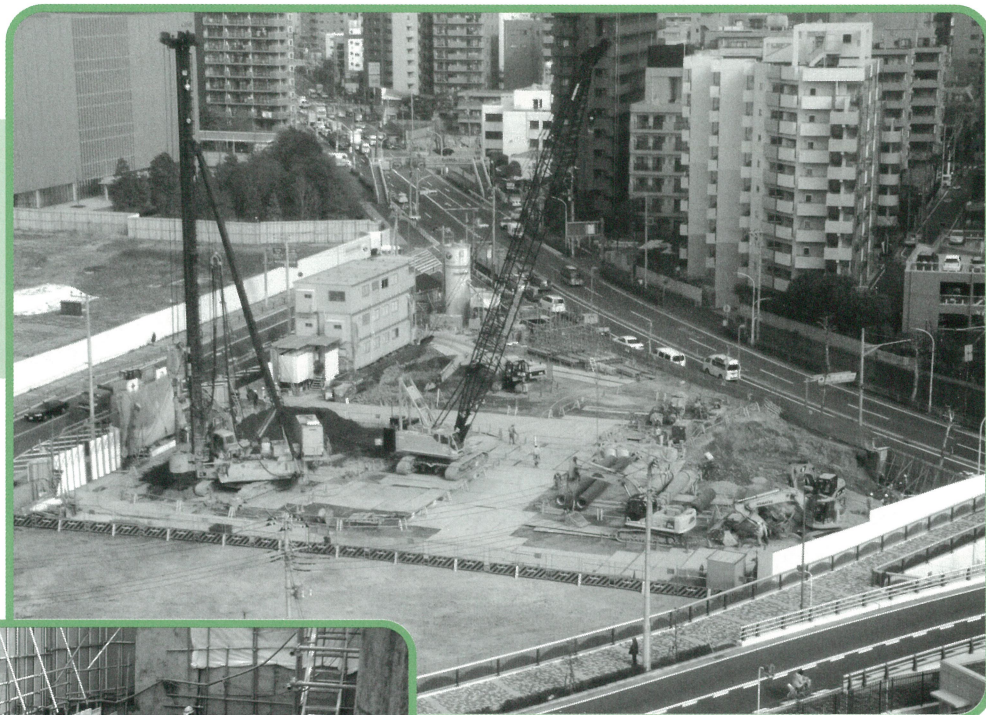
工事現場全体風景
