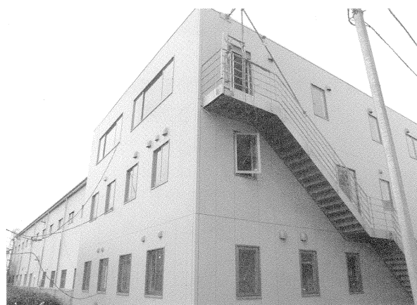
〈竣工間近の中央棟、左奥は改修予定の管理棟〉
